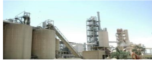
شكل (5) برج التسخين والتكليس المستعمل حالياً من قبل المصانع اليمينية (باجل، عمران)
