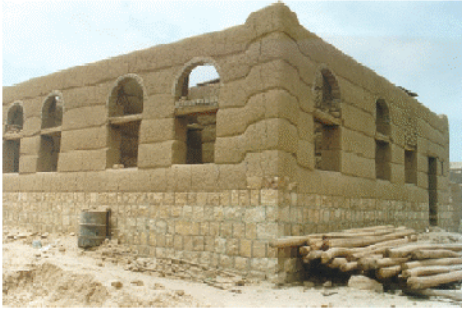
شكل رقم (17) مبنى قيد الإنشاء بتقنية الزابور في رحيان - صعدة (الباحث)
