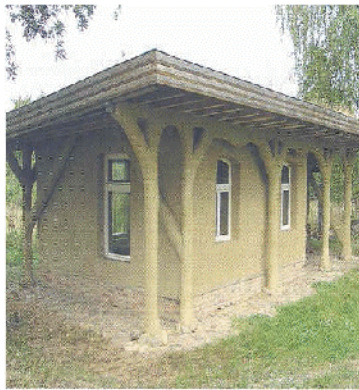
شكل (2) مبنى طيني جدرانه محمية بيروز انسقف ومقلات خشبية في ألمانيا (Minke,
