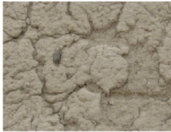
شكل (4) تأثير ظاهرة التورق في جدار الزابور المرمم لسور صنعاء القديمة (الباحث)
