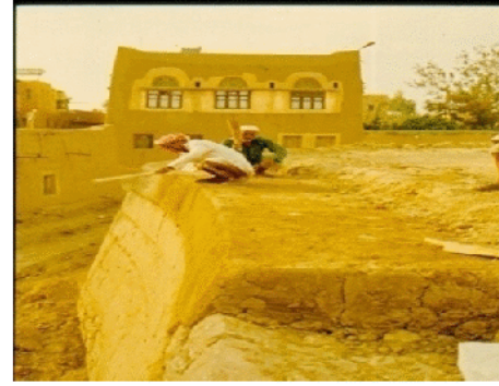
شكل رقم (16) إستخدام المضرب الخشبي في اليوم الثاني لبناء الرصة بغرض التسعيم وسد شروخ الانكماش ، السور التاريخي لمدينة صعدة (الباحث)
