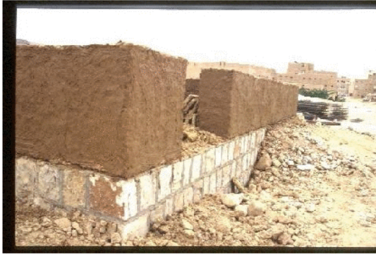
شكل رقم (12) تنفيذ طبقة المحضّة مباشرة بعد بناء الوافر (خمس رضات مدر) في مبنى قيد الإنشاء مقابل دار السلام في تريم (الباحث)
