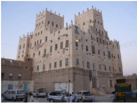
شكل رقم (14) قصر القعيطي في القطن مثال لتساقط التلايس الجيرية في المباني الطينية (الباحث)
