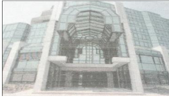
زجاج أخضر في مبنى Genex International في بلغراد
