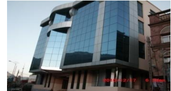
الواجهة الأمامية للمبنى
