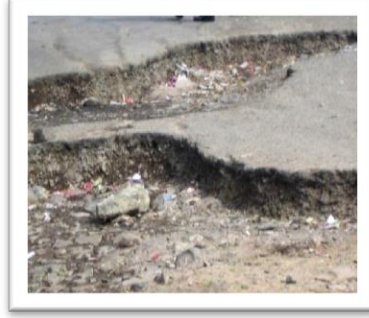
الشكل a3 يوضح المطبات المصطنعة لغرض تخفيف السرعة الشكل a3 يوضح الحفر الناتجة عن سوء التنفيذ وأضرار السيول
